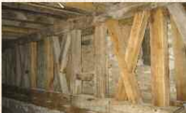
Vue partielle de la rénovation
